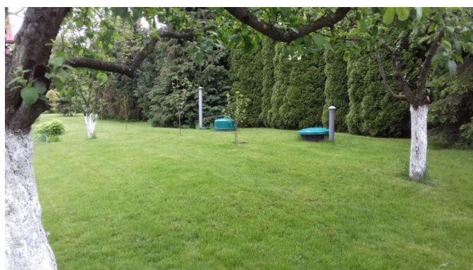
Jedna z 94 szt. przydomowych oczyszczalni ścieków.
