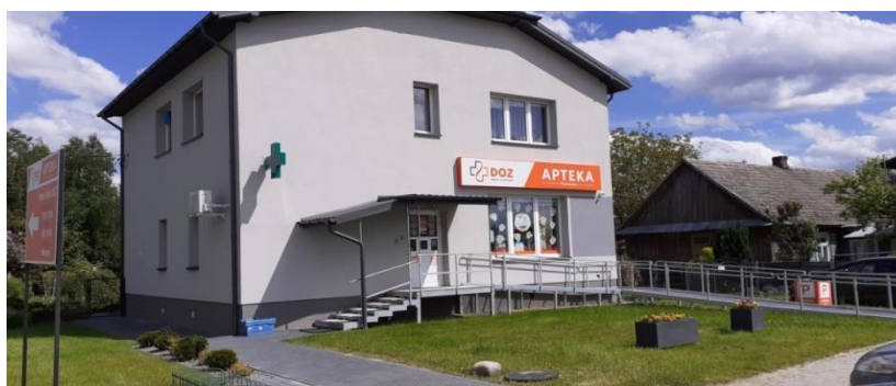
Modernizacja budynku apteki
